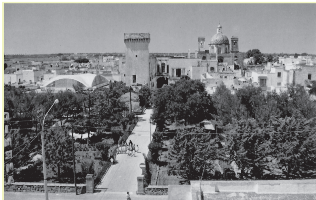
Torre ducale prima del restauro
