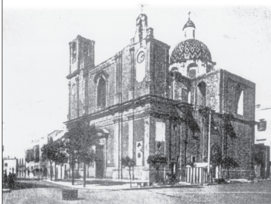
La Chiesa Madre tanti anni fa, con il vecchio campanile sulla destra (il nuovo fu costruito nel 1957)
